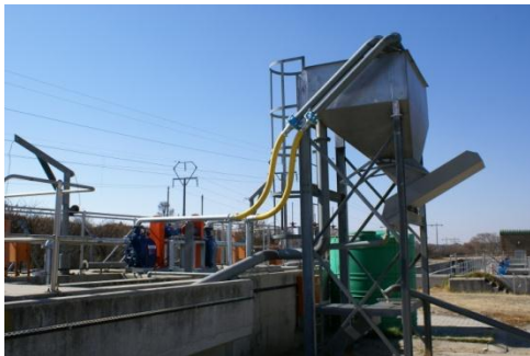
New Grit pumps (Kroonstad)
